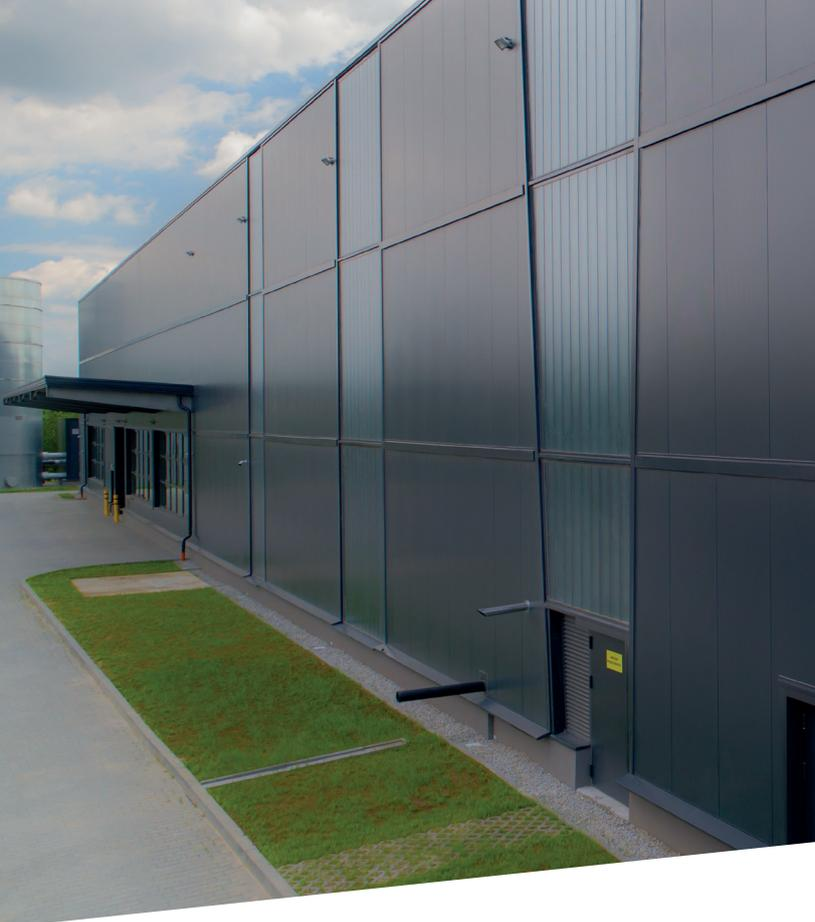
Die Sandwichpaneele ARPANEL AESTHETICS werden vor allem als Wand- und Dachverkleidung in folgenden Gebäuden eingesetzt:
